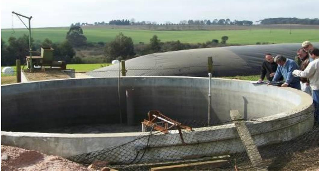
**Figura 3:** Vista general del depósito receptor de efluentes. Del lado opuesto al agitador hay una bomba que manda los efluentes cada 2 días al digestor principal que se encuentra, como se observa, muy cercano.
