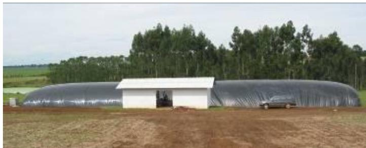
**Figura 11:** Vista externa del digester en pleno funcionamiento con su capa plástica protectora externa inflada por el biogás. En primer plano la sala donde se ubican los compresores, reguladores de presión, bombas inyectoras de oxígeno, filtros y motores eléctricos.
