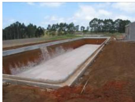
**Figura 5:** Construcción del digestor principal para almacenamiento de los residuos primarios del establecimiento y generación y captación del gas metano. Se observa el cordón en forma de "U" y la capa de arena sobre la cual se coloca la lona plástica para impermeabilizar la fosa.
