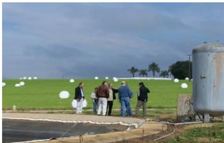
**Figura 18:** Vista parcial del depósito de biofertilizante. A la derecha de la foto el depósito de biogás que genera este y que utiliza para la agitación del digestor primario.
