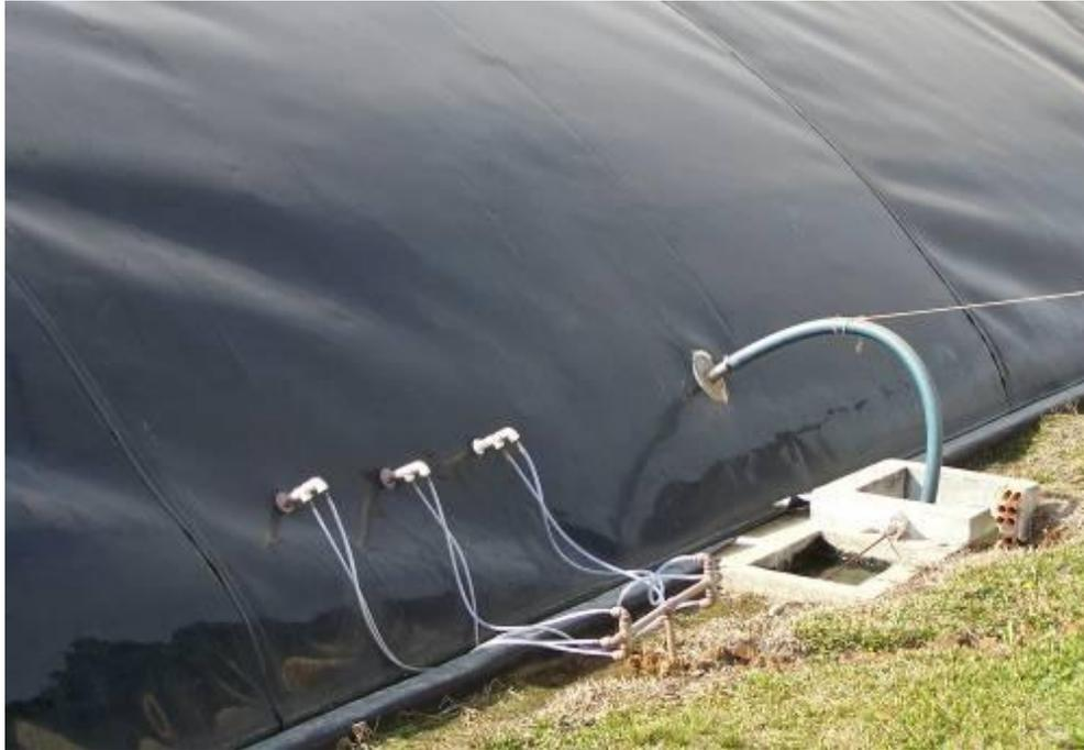
**Figura 15:** La foto muestra la entrada de 3 de las 6 mangueras que inyectan oxígeno al biodigestor primario. La manguera de mayor diámetro es la que conduce el biogás al compresor para que lo comprima en un depósito externo. Desde este depósito se manda el biogás a la red que lo distribuye en el establecimiento.
