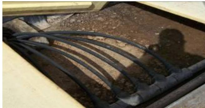
**Figura 8:** Vista de la entrada de agua caliente proveniente de la refrigeración del motor co – generador de energía eléctrica que se encuentra en la sala de maquinarias al costado del digester principal. La entrada de la cañería plástica es por la punta del digester.
