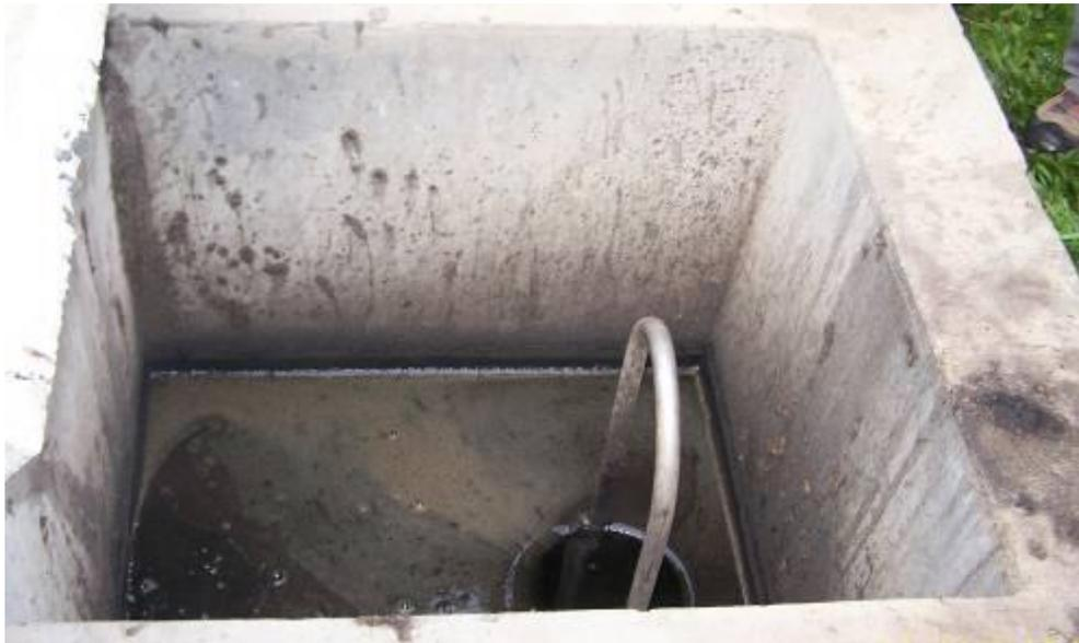
**Figura 17:** Cámara que actúa por rebalse. Se accionan cuando se carga el digestor primario. Este tipo de cámara se encuentra al costado de los galpones de cerdos, conectadas a las fosas de los galpones. Por el mismo sistema (gravedad) se carga el depósito de efluentes antes de la entrada al digestor primario.
