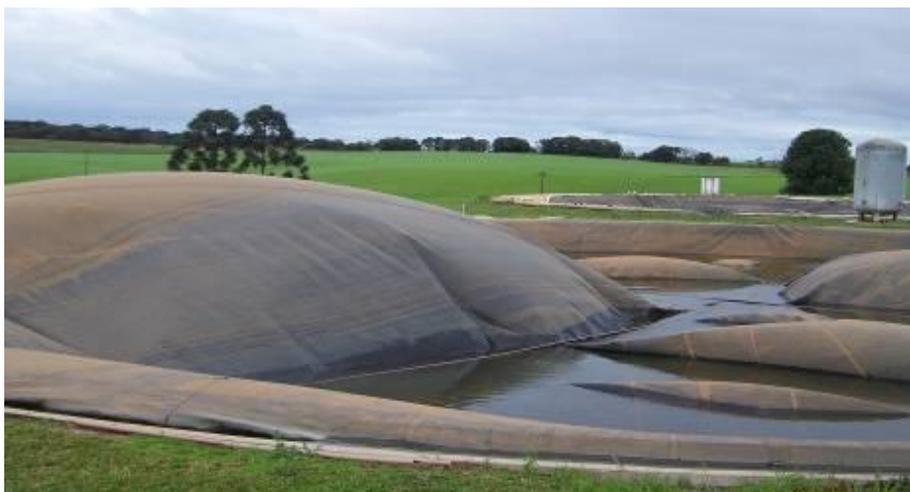
**Figura 16:** Vista del digestor secundario y detrás el depósito de biofertilizante. Ambos construidos en forma circular con un cordón de hormigón armado en forma de "U" y revestidos internamente y externamente, al
