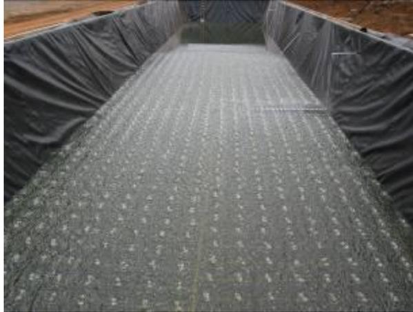
**Figura 7:** Sistema de recirculación de biogás en funcionamiento, previo llenado del digester con una capa de agua. La foto muestra la prueba del sistema antes de ser llenado y tapado, el burbujeo del gas o presión es lo que muestra la foto.
