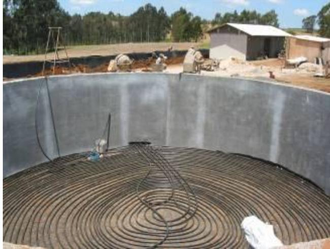
**Figura 1:** Vista de la construcción del depósito en dónde llegan todos los efluentes de los galpones de cerdos.
