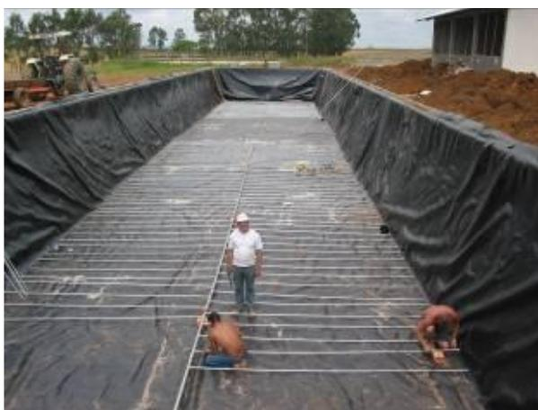
**Figura 6:** Instalación de las mangueras de recirculación de biogás en el fondo del digestor principal. Esta recirculación de gas desde el fondo del digestor favorece el ciclo de producción de metanol y evita la deposición de sólidos en el fondo del digestor. Obsérvese la capa aislante contra el piso de tierra. Este recubrimiento es una lona especial que tiene una vida útil de más de 20 años.
